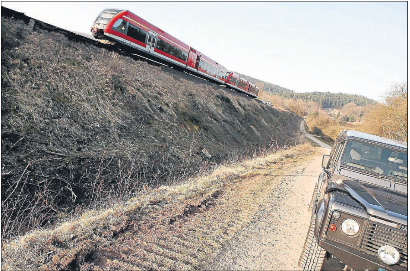
Zufahrt zum Zierenberger Bahntunnel: Beim Bau des neuen Durchstichs durch den Berg im Hintergrund werden 12 000 Lastwagen den Abraum abtransportieren. Damit der Kreisverkehr nicht durch die Stadt führt, sollen die Feldwege ausgebaut werden. Foto: Norbert Müller
